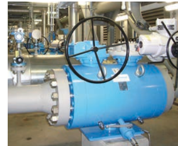
Twin Ball Valve-Sperrstrecke in der Gastrocknung als besonders platzsparende Variante für höchste Sicherheitsansprüche.
