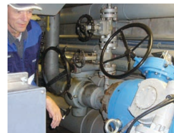
Betriebsleiter Markus Schuster freut sich über die Erneuerung der Sperrstrecke ohne Schweißarbeiten. Die kompakte TBV-Ausführung, die den geflanschten alten Kugelhahn ersetzt, macht es möglich.
